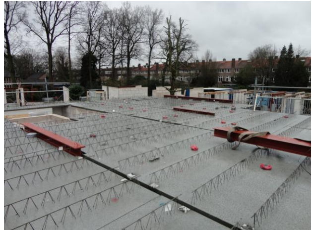
Kijkje op onze 1e verdieping in aanbouw
