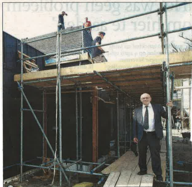
Directeur/bestuurder Ed Smolders bij de energieneutrale Glorieux-nieuwbouw. In september moet de woonruimte klaar zijn. foto Irene Wouters
