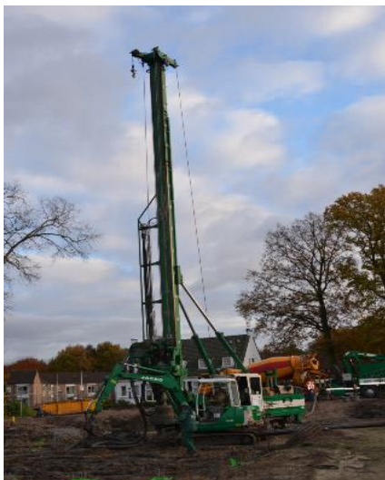
Boren funderingspalen gebouw Ronse
